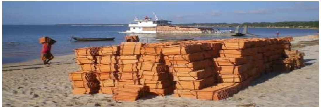
Entrega de material de construção a populações tradicionais
